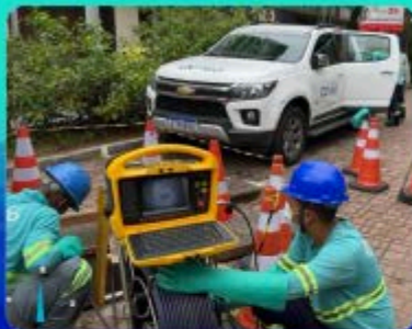
Vídeo Inspeção de Rede
