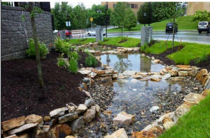
Figura 25 - Biovaleta. Fonte: Beckley Sanitary Board.
